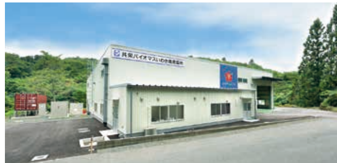
プラント全景写真
