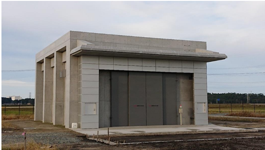
連続稼働耐久試験棟
