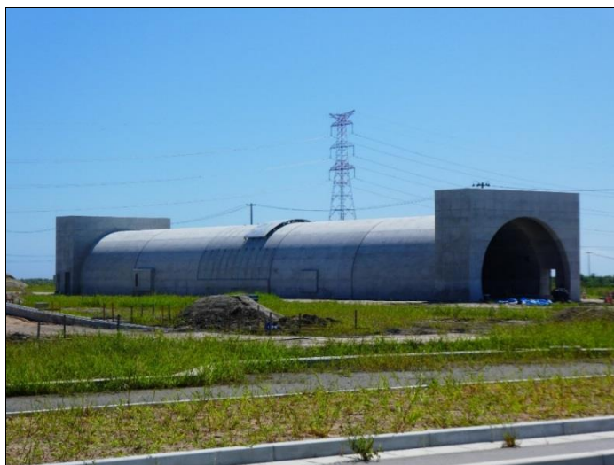
試験用トンネル
