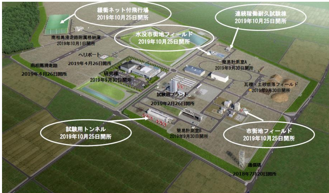
RTFの開所済み試験施設
