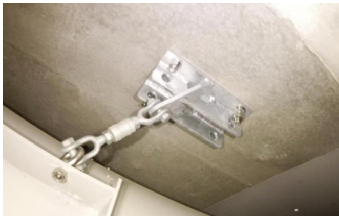
<図 2-14: 天井のアンカーボルトの様子>
