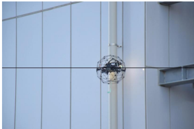
< 図 2-5: 近接飛行による損傷の点検の様子 >
