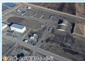
⑤ 瓦礫・土砂崩落フィールド
