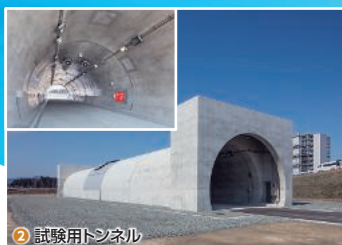
② 試験用トンネル
