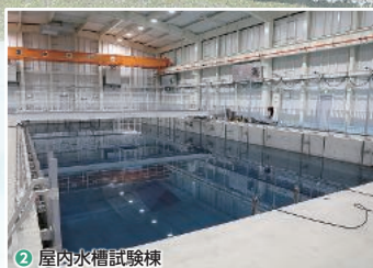
② 屋内水槽試験棟
