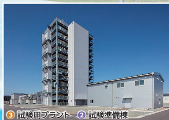
③ 試験用プラント ② 試験準備棟
