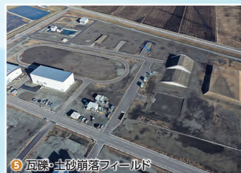
⑤ 瓦礫・土砂崩落フィールド
