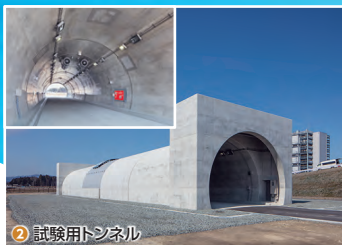
② 試験用トンネル
