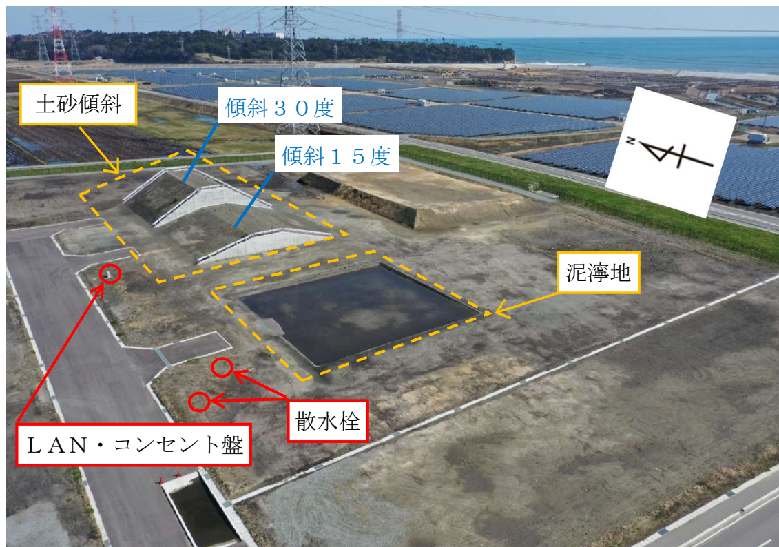
瓦礫・土砂崩落フィールド外観（土砂傾斜、泥濘地）
