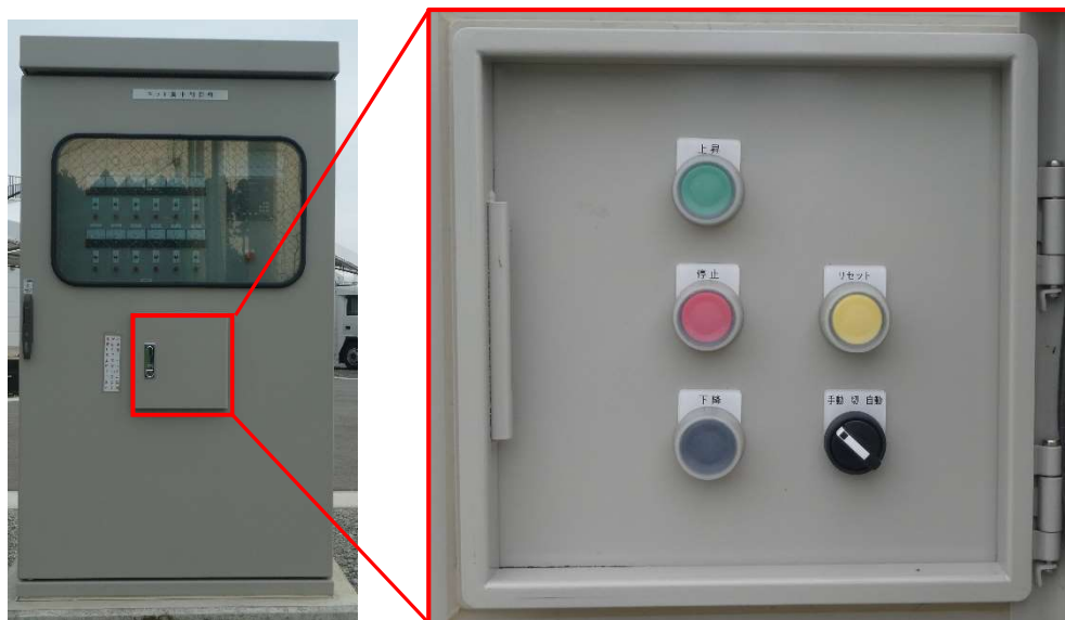
ネット集中制御盤
