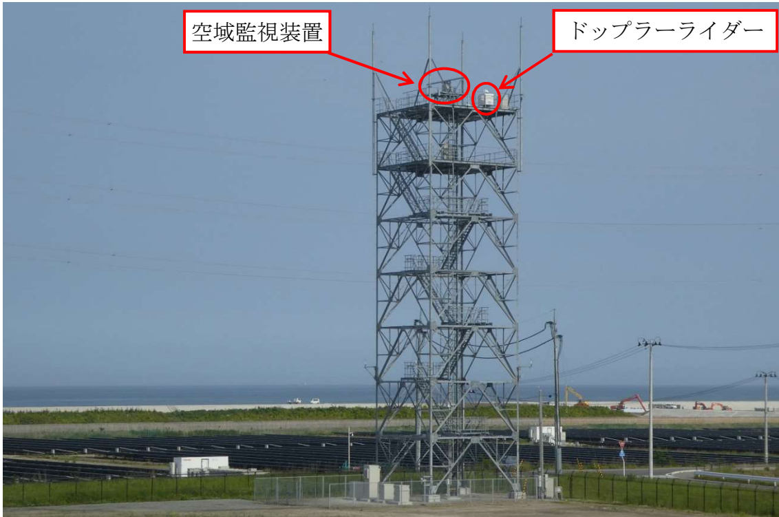
通信塔外観 (写真は南相馬のもの)
