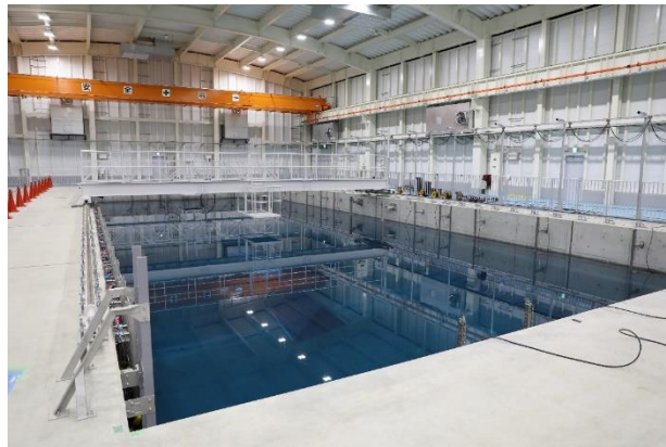
屋内水槽試験棟（大水槽）
