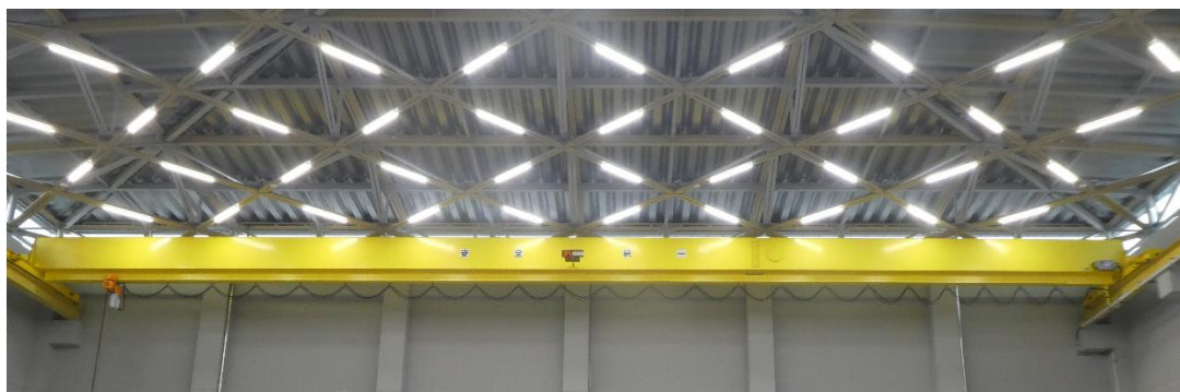
天井クレーン(2t)
