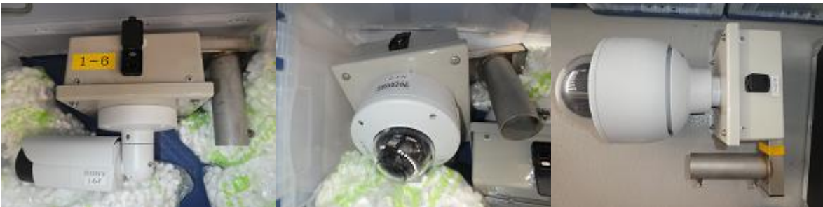
監視カメラ(左からボックス型 IP カメラ、ドーム型 IP カメラ、ペンダント型 IP カメラ)
