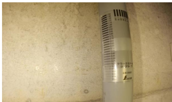
<図 2-15: 無人航空機により撮影されたトンネル内のクラックスケール>
