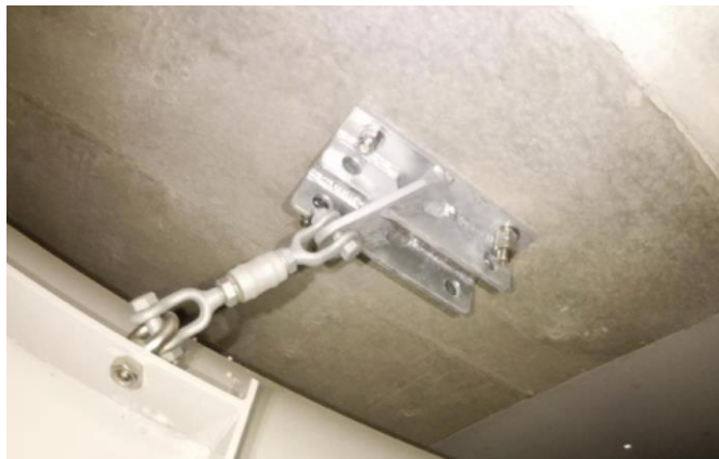
<図 2-14: 天井のアンカーボルトの様子>
