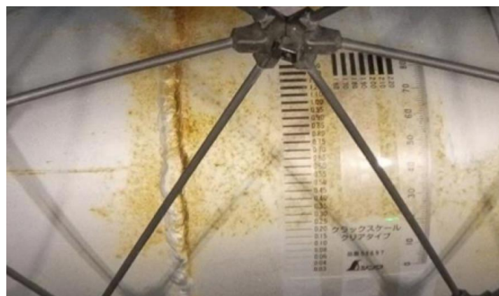
<図 2-9: 無人航空機により撮影されたパイプとクラックスケール>
