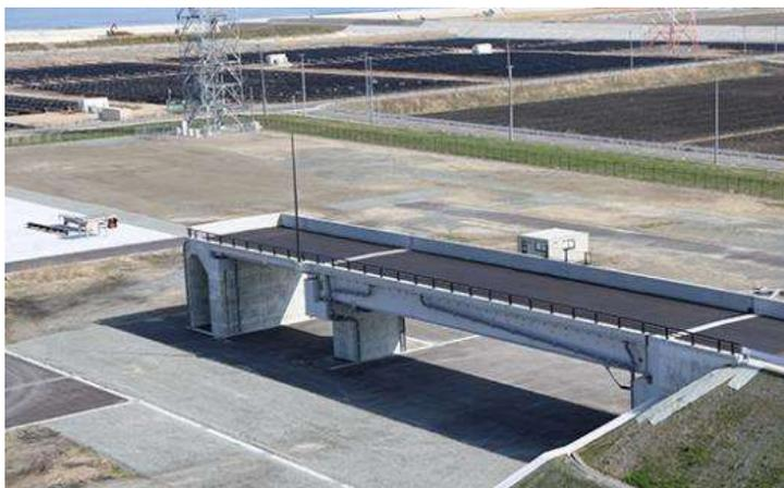
鋼・コンクリート製の4種類の形状の橋梁で、老朽化や障害物を再現し、状況確認や点検に関する試験や操縦訓練を行う施設です。点検対象となるコンクリートのひび割れ・剥離・うき、鋼材のボルト緩み・亀裂や、点検時に障害となる照明柱や防護柵を再現しており、トラス、ケーブル管等も設置できます。
