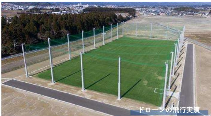
上面・周囲をネットで覆った航空法適用外の飛行場です。風雨・日照のある野外環境下で、無人航空機の基本的な飛行性能や自律制御等の評価試験、操縦訓練を行うことができるほか、夜間飛行、物件投下などを法律上の事前申請なしで実施可能です。
