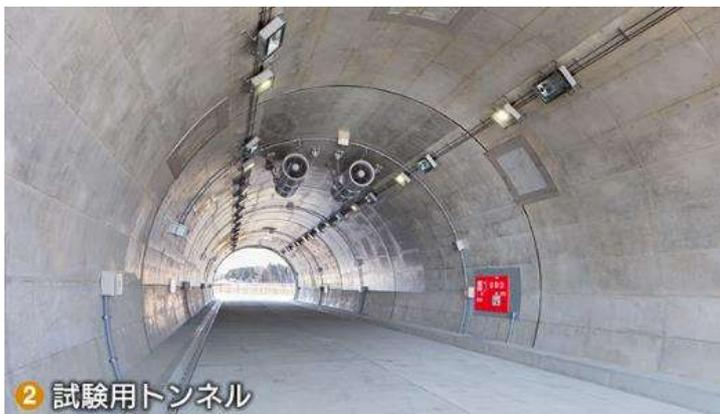
トンネル中での交通事故、崩落、老朽化を再現し、状況確認、捜索、瓦礫除去、老朽化点検に関する試験や操縦訓練を行う施設です。高速道路や一般道の照明（LED灯、ナトリウム灯）、ジェットファンなどを設置し、壁面には点検対象となるひび割れやうきを再現しています。内部に車両、瓦礫、岩石、土砂など障害物を自由に配置・固定できるほか、両側シャッターを閉鎖して長大トンネル中央部を再現できます。
