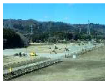
剥ぎ取り除染後の農地
