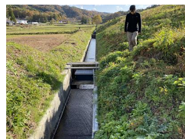
傾斜地からの放射性物質流出調査
