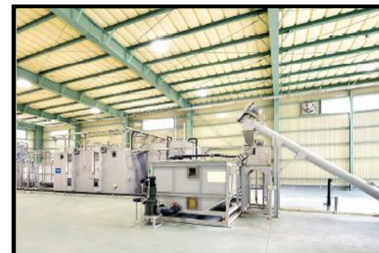
田人プラント内部全景
