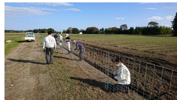
特別インターンコース(鳥獣対策フェンス設置)の様子
