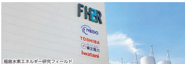
福島水素エネルギー研究フィールド
