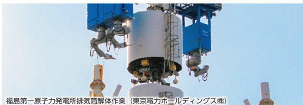
福島第一原子力発電所排気筒解体作業 (東京電力ホールディングス株)
