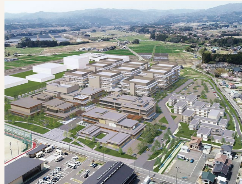
▲地区北東側(上空)から見た外観
