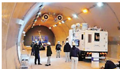
カメラ、レーダー、レーザーによるトンネル内部欠陥の検出
